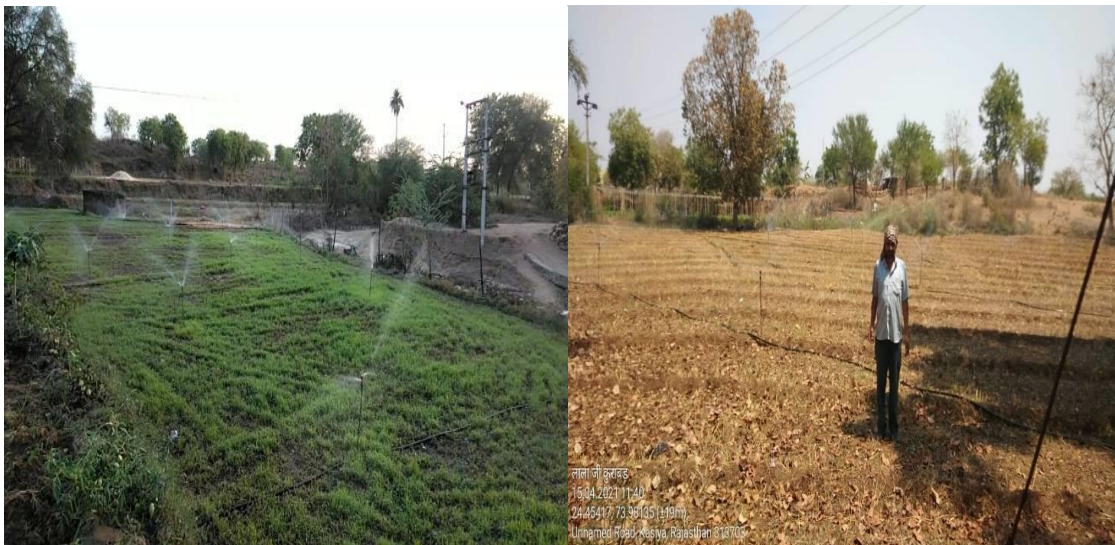
Mini Sprinkler System
